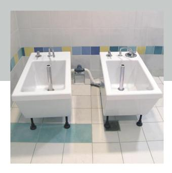
Cet ensemble est composé de deux bacs de forme rectangulaire. Chaque bac comprend une alimentation en eau mitigée avec bec verseur, robinet de remplissage et bonde à surverse formant un trop plein.
